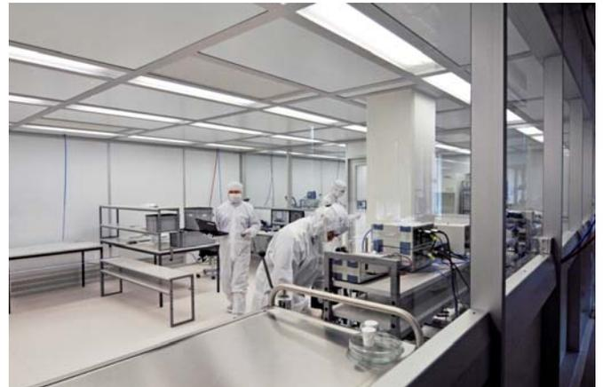
Optikbauteile Montage, Optotune AG Reinraumsystem CleanCell, ISO- Reinraumklasse 6
